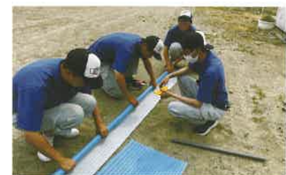
断熱作業の様子
