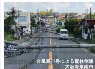
台風第21号による電柱倒壊 大阪府泉南市
