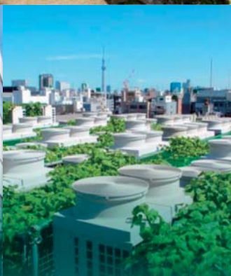
第20回 都市緑化機構会長賞 壁面・特殊緑化部門 住友商事美土代ビル 室外機芋緑化
